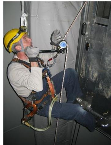
10. Sicherheitssteigleiter bis unter das Podest aufsteigen. Oberes Ende des Rettungsseils am Rettungsgerät straff ziehen und Steigschutzläufer vom Rettungsgurt lösen. Am Rettungsseil hängend, zur Fahrkorbtür hinüberschwingen.
