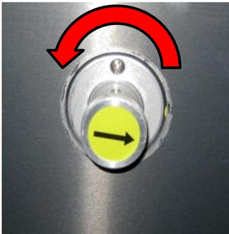
11. Die Notentriegelung gegen den Uhrzeigersinn eine halbe Umdrehung drehen. Die Fahrkorbtür öffnen und in den Korb steigen.
