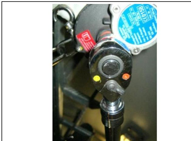
3. Rettungsgerät und Knarre am Hebel auf „rot“ stellen und zur Einhausung bzw. dem oberen Teil des Fahrkorbes abseilen.
