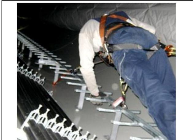
1. An der Sicherheitssteigleiter 5-7 Meter hochsteigen und die lange Bandschlinge oberhalb der Aufstiegshilfe an einem geeigneten Anschlagpunkt befestigen.
