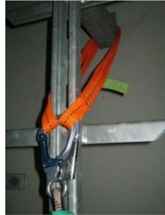
2. Die lange Bandschlinge ca. 5-7 Meter oberhalb des Podestes an einem geeigneten Anschlagpunkt befestigen. Den Karabiner des Rettungsseils in die Bandschlinge einhängen.
