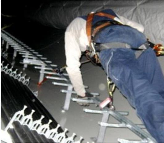
1. Mit Hilfe der Sicherheitssteigleiter bis zum nächst höheren Podest über dem Fahrkorb aufsteigen.
