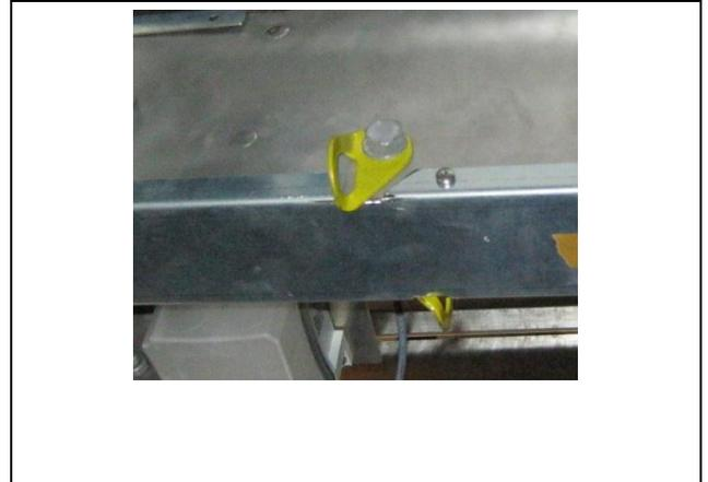
2. Vor dem Öffnen der Fahrkorbtür die eigene Sicherung an einem Anschlagpunkt sicherstellen/ kontrollieren.
