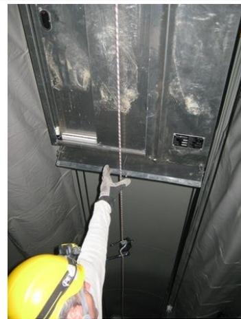
8. Sicherheitssteigleiter so weit absteigen, bis das Rettungsseil und das Rettungsgerät gefasst werden kann, ggf. ist dies erst auf dem darunter befindlichen Podest möglich.
