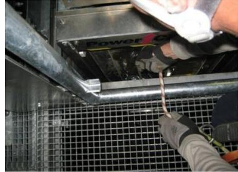
6. Rettungsgerät durch den Spalt zwischen Podest und Fahrkorb hinabführen, bis das Gerät nach dem Abhängen ca. vor der Tür der Aufstiegshilfe hängt.
