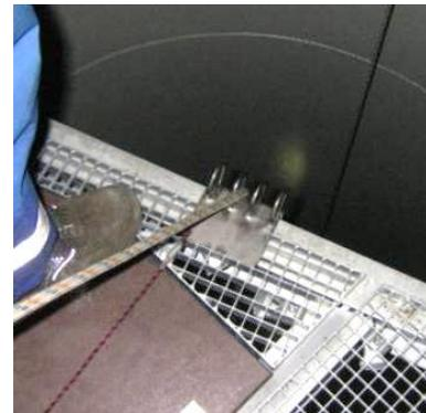
4. Kantenschutz auf das Podest oder den Einhausungsrahmen setzen und gegen Herabfallen sichern.
