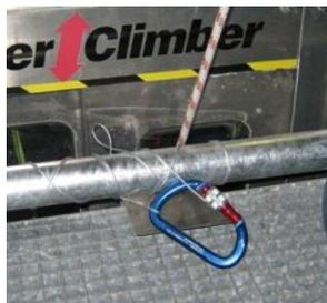
7. Kantenschutzblech am Podestrahmen auflegen und gegen Herabfallen sichern. Das Rettungsseil über den Kantenschutz laufen lassen.
