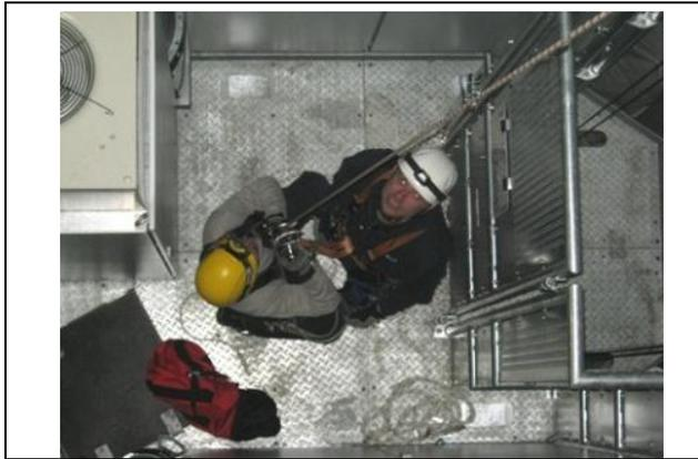
5. Seil über das Kantenschutzblech führen und bis zum nächsten Podest oder einer geeigneten Stelle abseilen.
