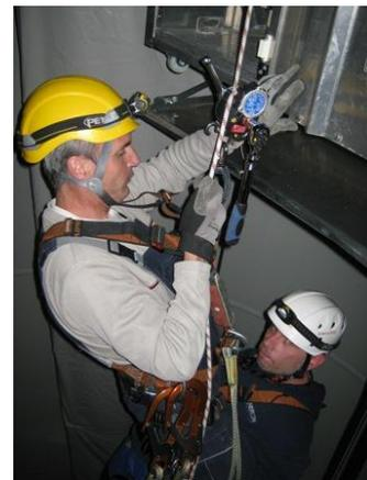
12. Mittels kurzer Bandschlinge werden die Brustösen der beiden Personen verbunden, alternativ kann die Brustöse des Retters mit der Rückenöse der zu rettenden Person verbunden werden.
