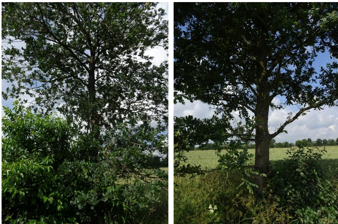
Abbildung 9: Blick auf die zu rodenden Eichen im Bereich der Zuwegung zur WEA 02 (Datum: 28.06.2024)
