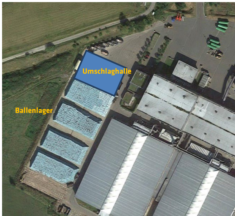
Abbildung 5.5 Luftbild des Kurzzeitlagers mit Kennzeichnung der Anlagenbereiche (Luftbild: google maps)
